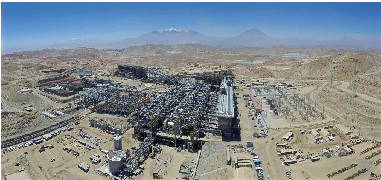
Vista aérea de la Concentradora C2
